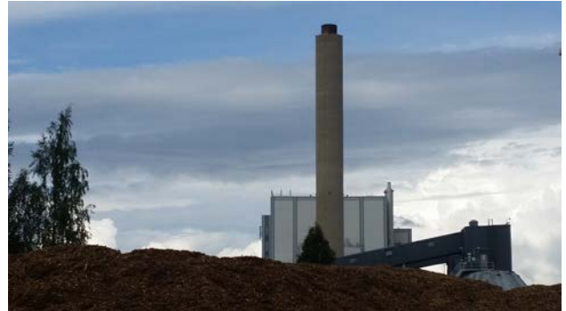
Vierailu Pohjolan Voiman Vaasassa sijaitsevalle Vaskiluodon CHP-voimalaitokselle elokuussa 2016.
